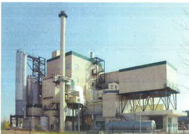
RDF Power Plant, Hagenow, Niemcy 50 000 Mg RDF/rok
