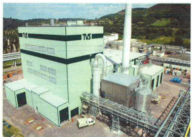
ZASO RDF- Power Plant, Rudolstadt, Niemcy 60 000 Mg RDF/rok
